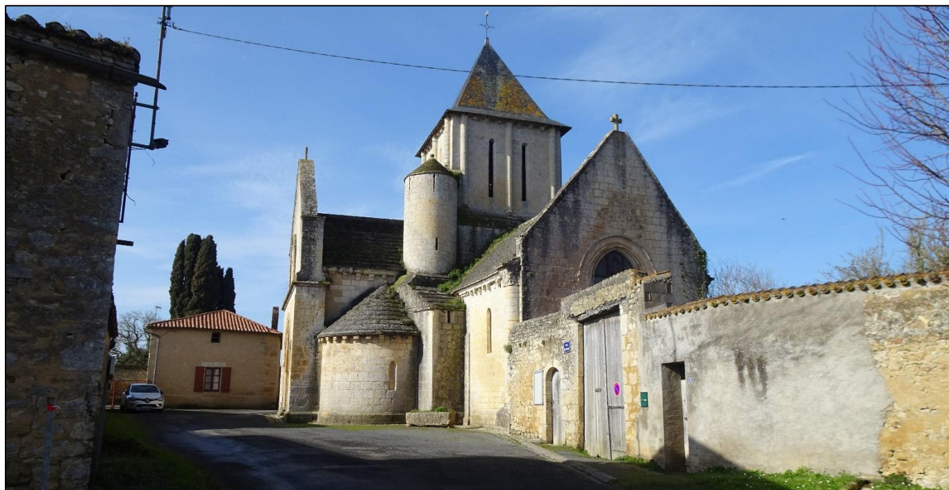
Figure 156 : Prise de vue 1 - Photographie de l'Eglise Saint-Jean-Baptiste capturée en direction du site d'étude (Crédit photo : NCA Environnement)
